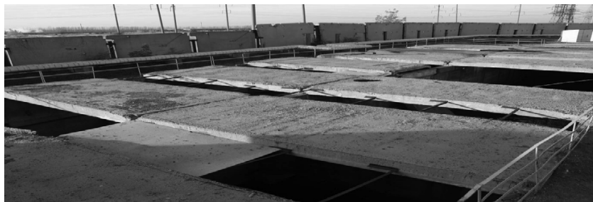
Рис. 1. Недействующая нефтеловушка в цехе № 2 УТТ и СТ
