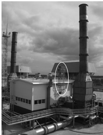
Рис. 1. Газоперекачивающий агрегат с безвозвратными потерями газа
