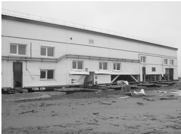
Рис. 2. Разрушительный эффект от шторма на здание морского порта Варандей
