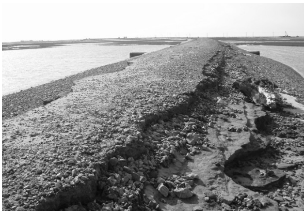
Рис. 1. Последствия волнового воздействия на дорогу Варандейский терминал—Морской причал
