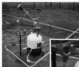
Рис.1. Двустенная емкость хранения одоранта
